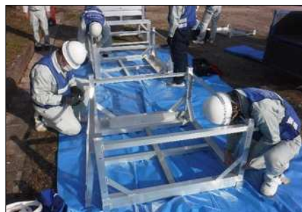
給水タンクの組立訓練
