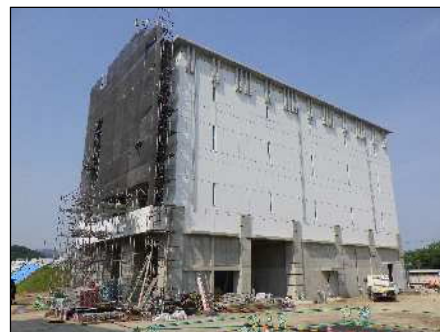
三野浄水場新脱水機棟
