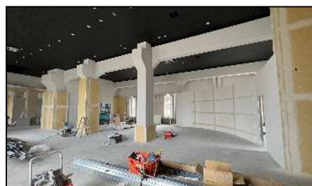
工事中の水道記念館
