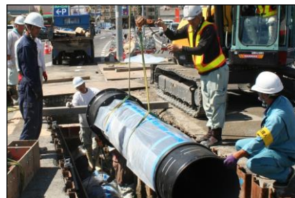
耐震管布設工事
