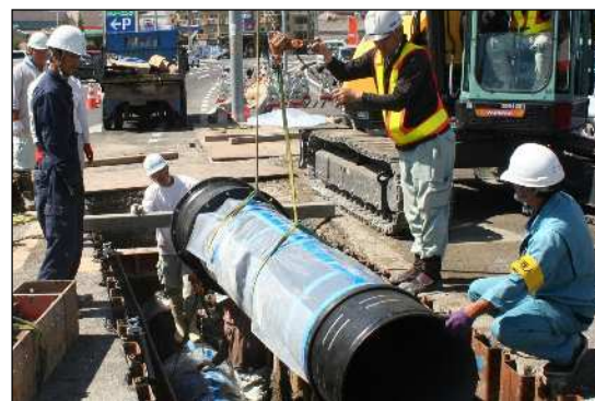
耐震管布設工事の様子
