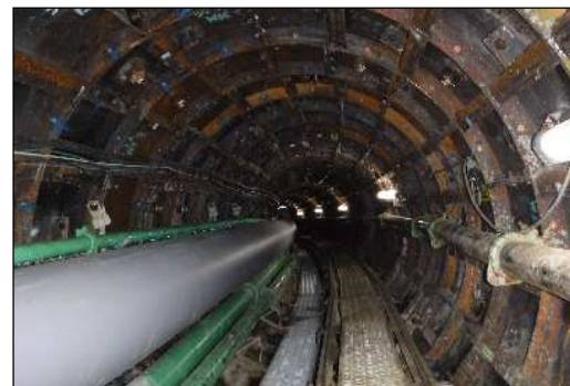
トンネル内部
