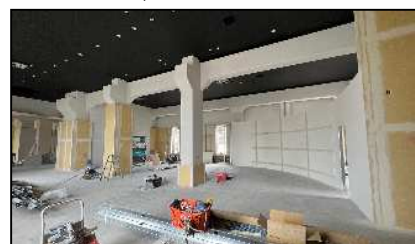
工事中の岡山市水道記念館
