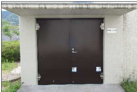
防水扉への取替
