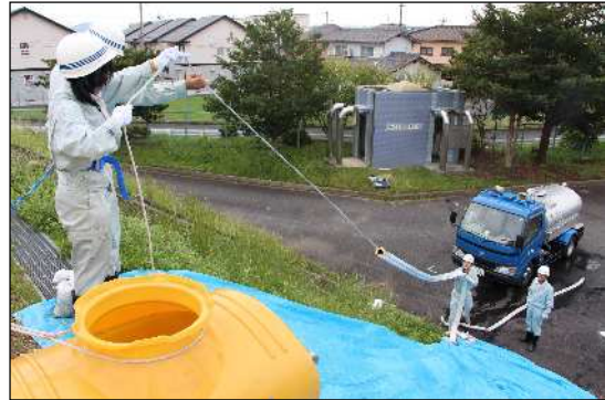
応急給水訓練/水道技術研修所 (高所への加圧給水)
