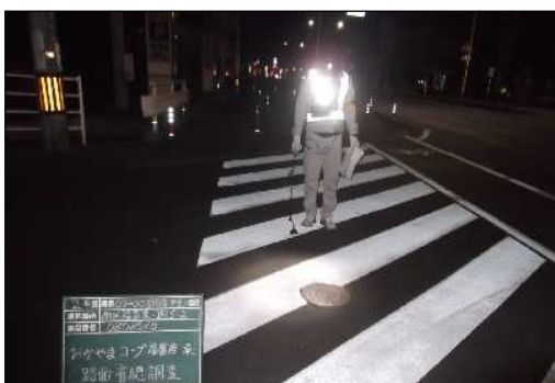
漏水調査/夜間作業の様子
