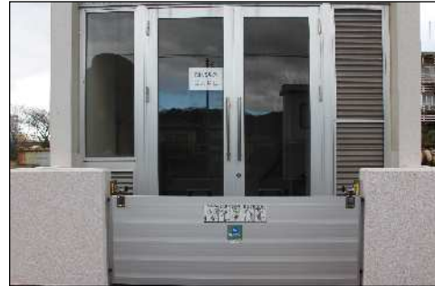
止水板の設置/三野浄水場
