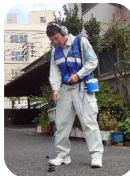
漏水探知機による漏水調査
