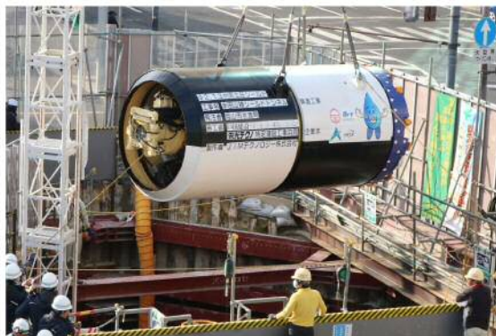
半田山線シールドトンネル築造工事
