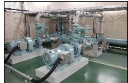
ポンプ設備の更新 (上土田加圧ポンプ場)
