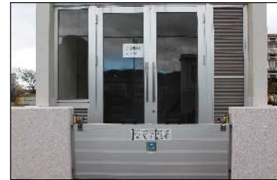
止水板の設置（三野浄水場）
