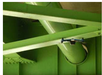
ドローン撮影による点検
