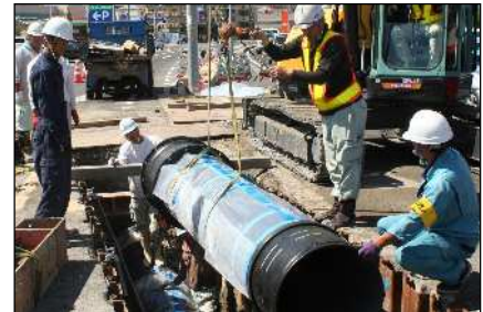
耐震管布設工事
