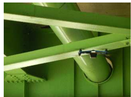
ドローン撮影による点検
