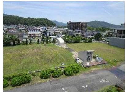
三野浄水場 浄水池
