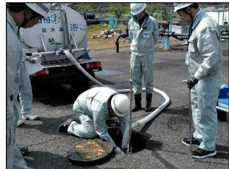
応急給水研修 (消火栓から給水車への充水)
