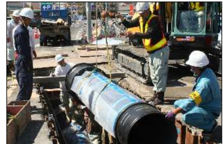
耐震管布設工事
