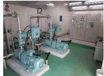
ポンプ設備の更新 (高野加圧ポンプ場)
