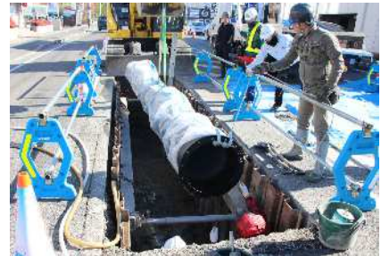
耐震管布設工事
