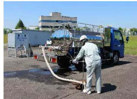
応急給水研修 (消火栓から給水車への充水)
