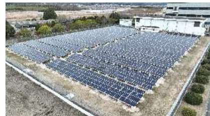
太陽光発電によるPPA事業 (旭東浄水場)
