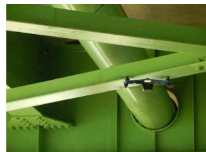
ドローン撮影による点検
