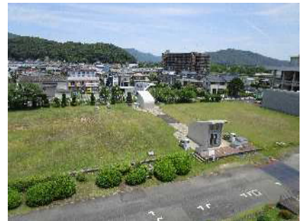
三野浄水場 浄水池
