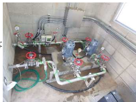
石引第1加圧ポンプ場ポンプ 取替工事
