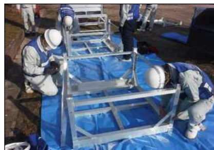
給水タンクの組立訓練
