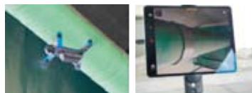
写真はドローンを使った水管橋の調査
