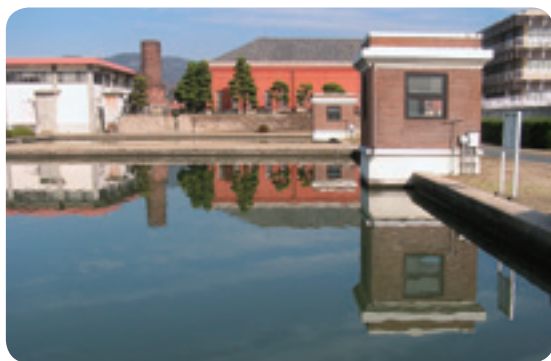
今なお稼働する三野浄水場の緩速ろ過池
