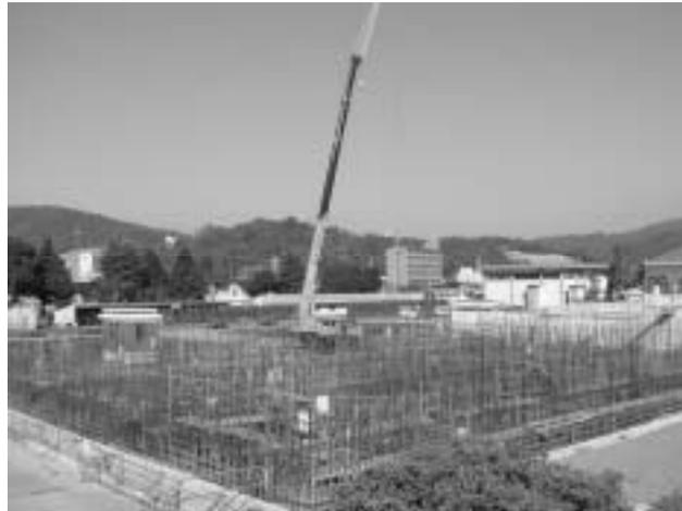
10 急速ろ過池/原水中の懸濁物質を凝集剤を用いて沈でん処理したあと、残っている濁質を一日120～150mの速い速度でろ過する装置(池)。岡山市の三野浄水場には32池あり、毎日稼働している。
