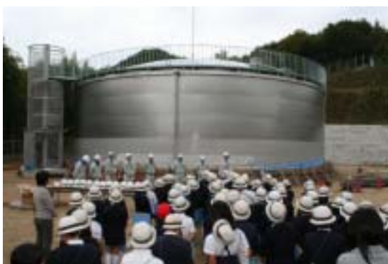
灘崎西配水池が完成し、彦崎小学校児童を招待しての見学会
