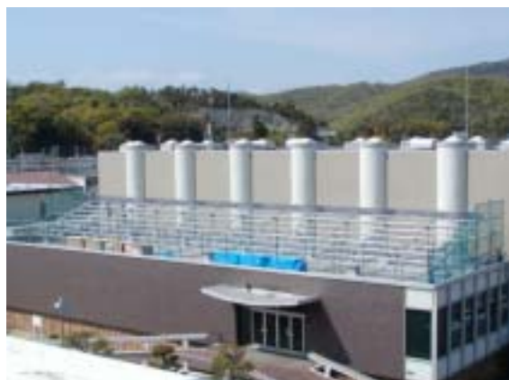
太陽光発電設備築造の様子
