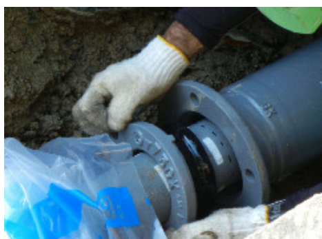
耐震管布設の様子
