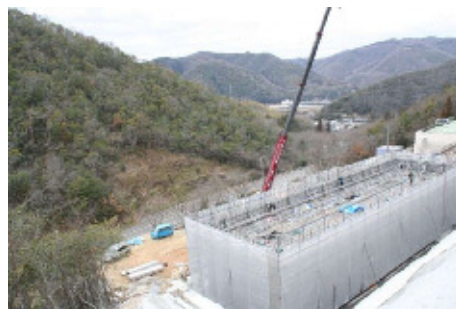
矢原配水池2池化工事
