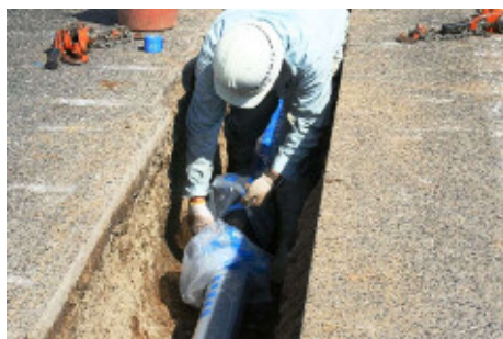
老朽管の更新工事の様子
