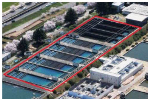
更新予定の薬品沈でん池
