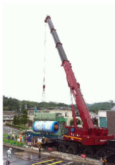
中央幹線布設工事の様子
