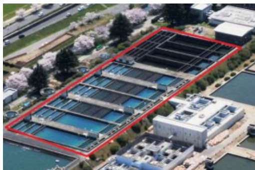
三野浄水場薬品沈でん池
