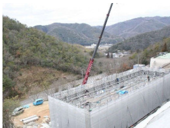
配水池の工事（矢原第2配水池）の様子
