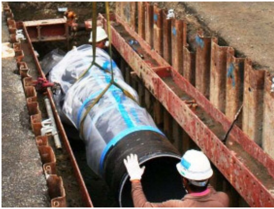
水道管の更新工事
