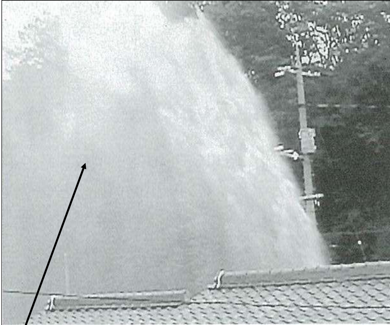
平成16年10月 東区東平島口径200mm配水管破裂事故 ⇒ 上道、南古都地区2,300世帯で断水
