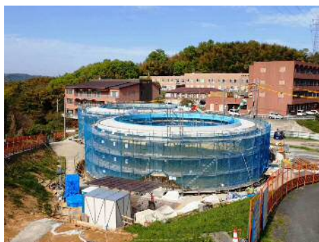
配水池の工事（富山配水池）の様子
