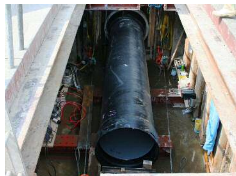
水道管の更新工事
