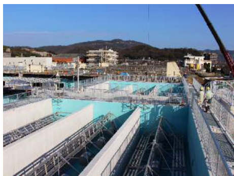
施工中の三野浄水場薬品沈でん池工事
