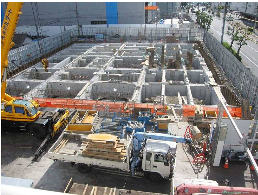
基礎工事中の本局新庁舎
