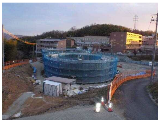
工事に着手した富山配水池
