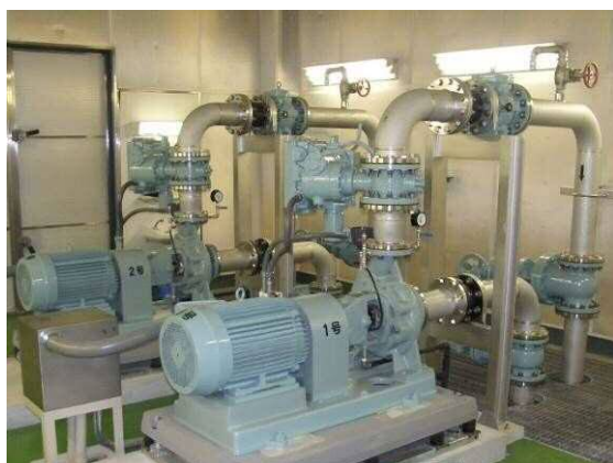
取替工事が完了した 菅野第1加圧ポンプ場
