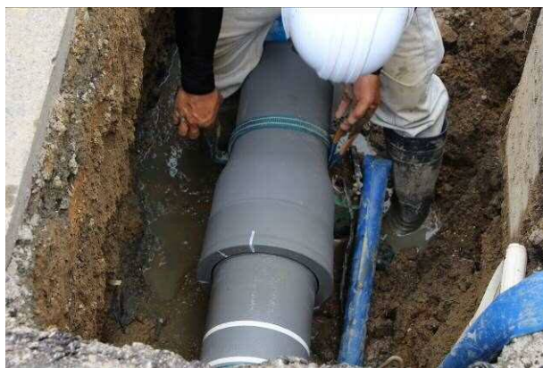
水道管の更新工事
