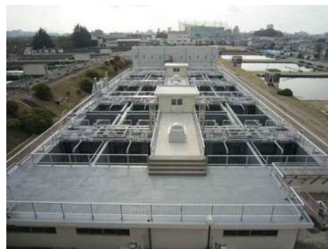
更新後の三野浄水場急速ろ過池
