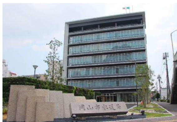
完成した本局新庁舎
