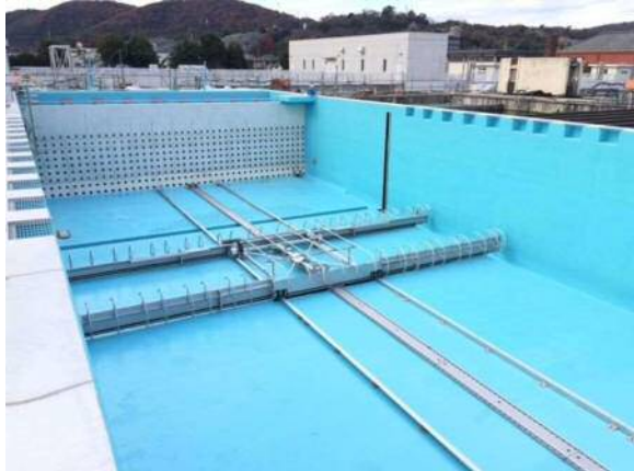
施工中の三野浄水場薬品沈でん池
