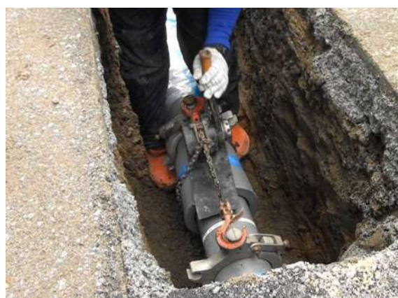
水道管の更新工事
