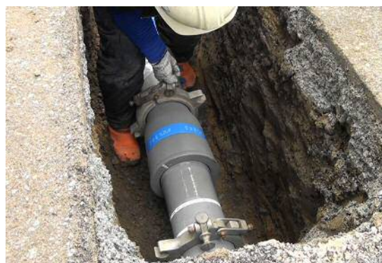
耐震管の布設工事
