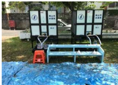
【②組立式給水タンク(倉敷市)】
