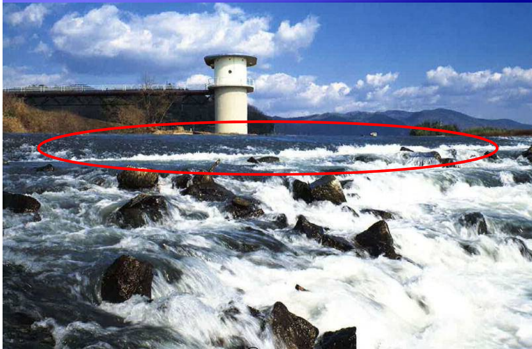
三挺樋堰崩壊前
