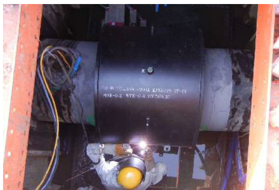
既存管路継手部分への耐震金具の取付
