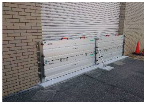
三野浄水場送配水ポンプ棟浸水対策
