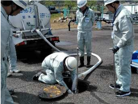
応急給水訓練の様子 (消火栓から給水車への充水作業)
