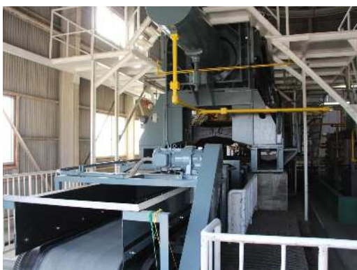
三野浄水場脱水施設
