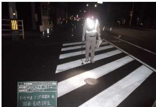
漏水調査/夜間作業の様子
