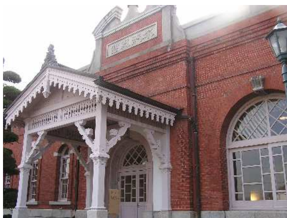
① 三野浄水場旧動力室・送水ポンプ室
