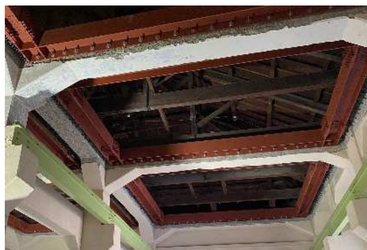
天井に鉄骨ブレースを新設 /水道記念館の耐震補強
