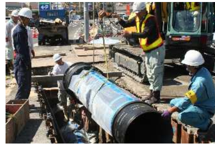
耐震管布設工事の様子
