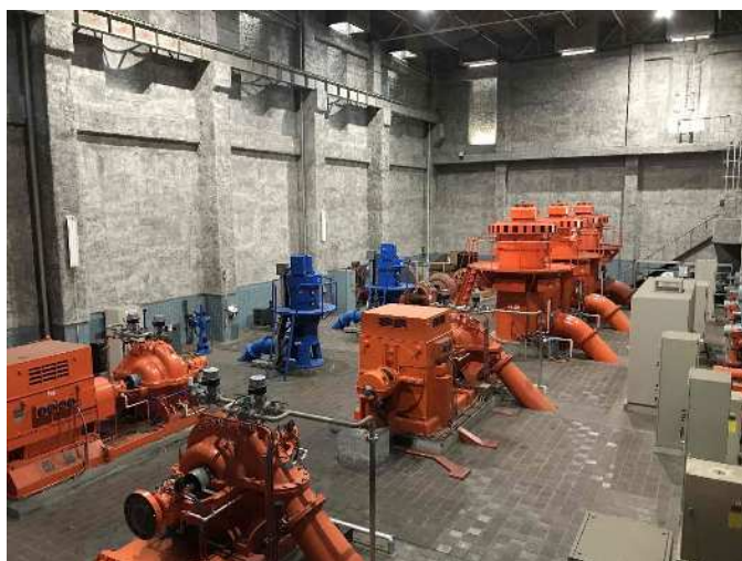
参考:三野浄水場 既設送配水ポンプ設備 および 工業用水道紫外線処理設備
