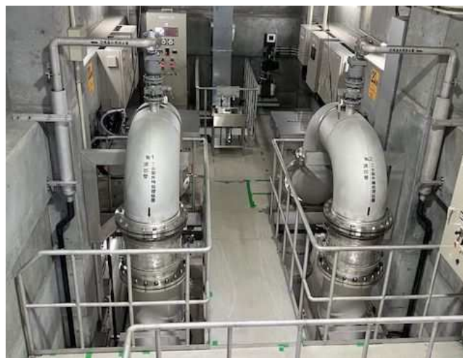
参考:三野浄水場 既設送配水ポンプ設備 および 工業用水道紫外線処理設備
