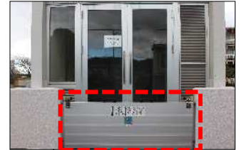
止水板の設置(三野浄水場)
