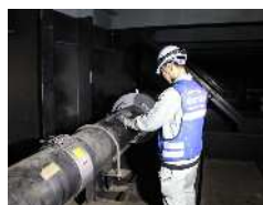
水管橋の点検(児島湾大橋)
