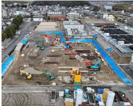
耐震化工事中の三野浄水場
