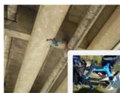
ドローンによる水管橋の点検
