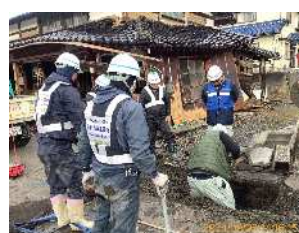
応急復旧作業 (能登半島地震)
