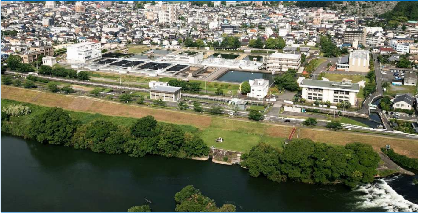
三野浄水場全景
