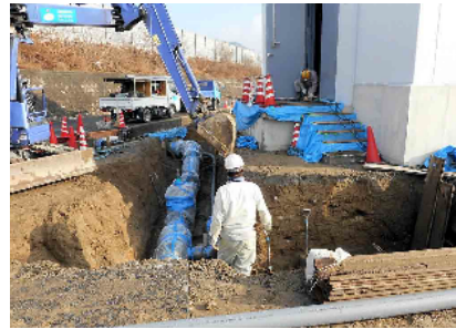
φ400流出管布設
